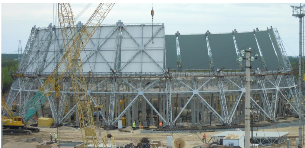
Рис. 1. Монтаж первого яруса башенной градирни НГРЭС
