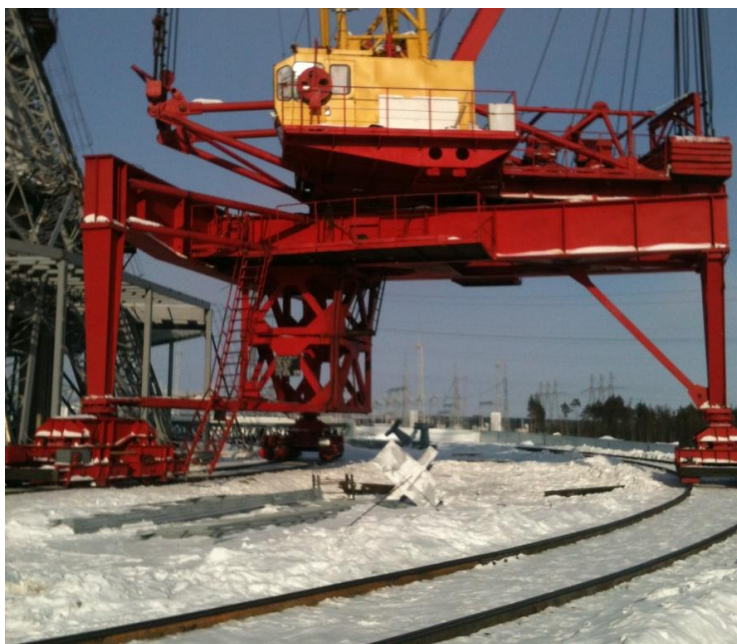
Рис. 2. Общий вид подкрановых путей
