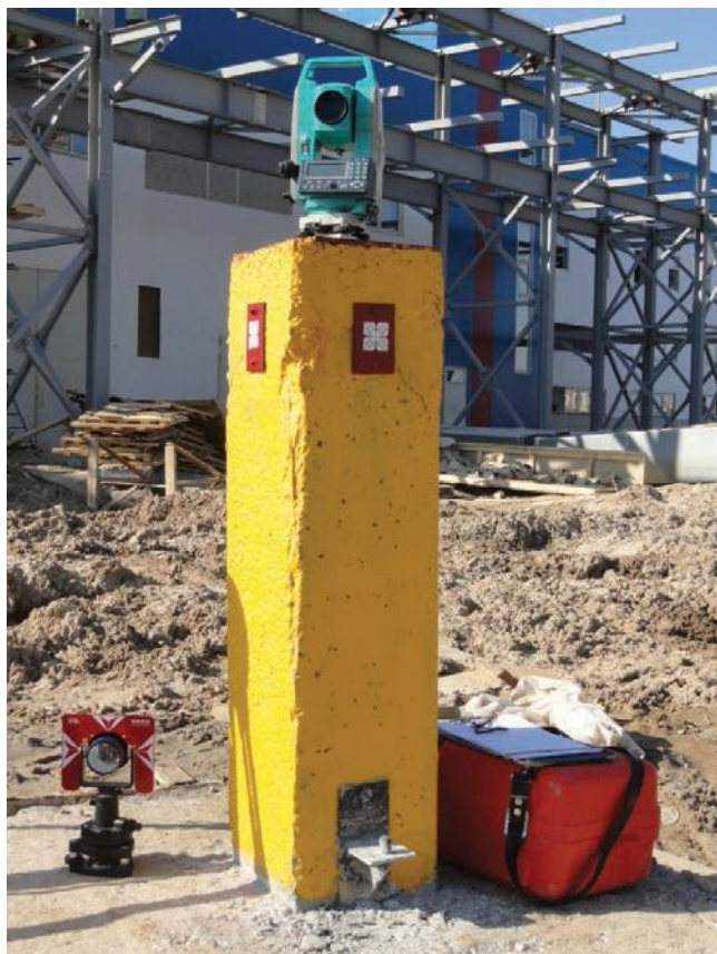
Рис. 3. Свайный геодезический пункт конструкции ОАО «Сибтехэнерго»
